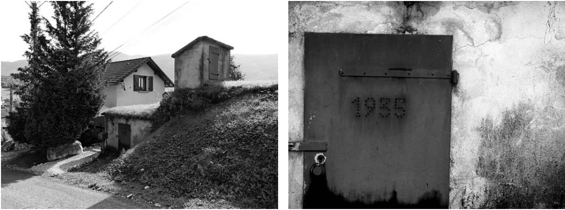
Ph. 38a et 38b. Le réservoir « Ancien Richerot » (1935).
