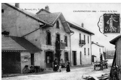
Ph. 14e. Vue de l'ancienne buanderie (CP 131 du site PHC).
