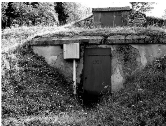
Ph. 41. Réservoir de Monnetier-Crêt (1938).
