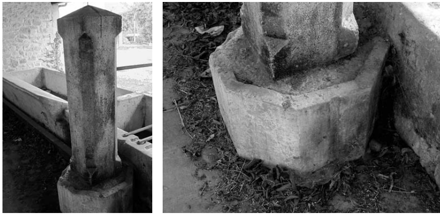
Ph. 22d et 22e. La base octogonale du pilier est un réemploi, semblant provenir de l'ancien lavoir qui se trouvait en face...
