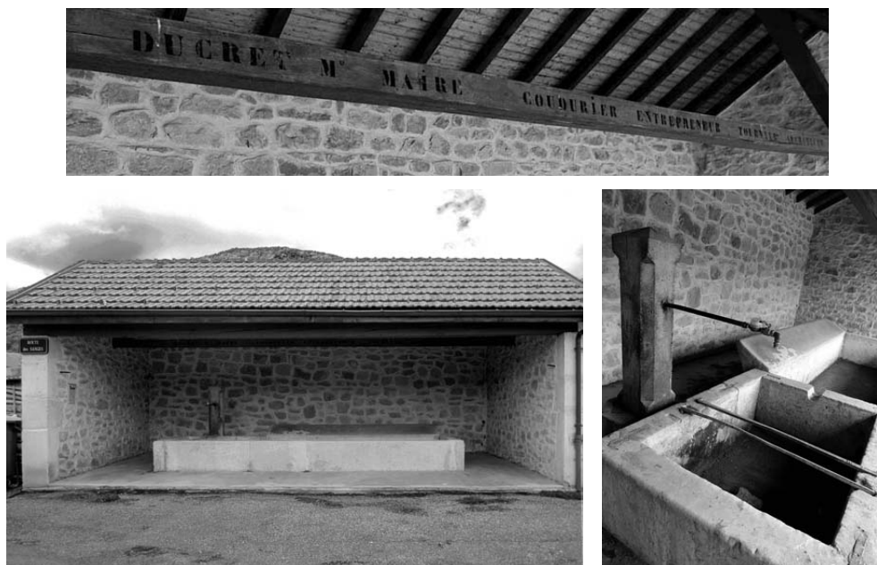
Ph. 22a-c. Lavoir restauré de la placette de Communal, avec mention des intervenants sur la poutre centrale (1905/08).
