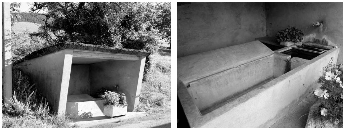
Ph. 17a et 17b. Le nouveau bac du Bordaz, est en béton, du sol à la toiture !
