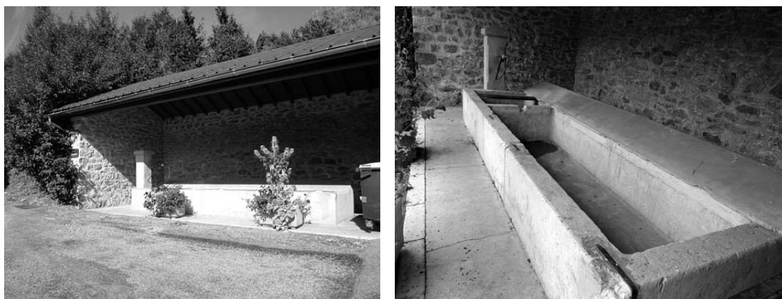
Ph. 3a et 3b. Le lavoir de Champbrun (Champ-Brun) est l'un des rares à être équipé d'un pilier aligné avec les bacs (et dont la couverture du bâtiment est en tôle).
