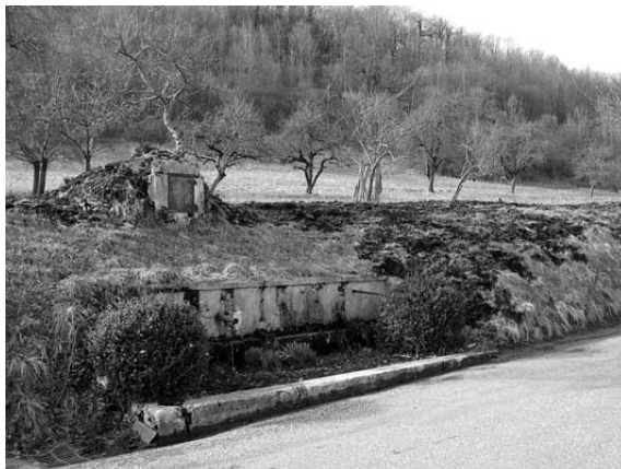
Ph. 13. Le bac de la platière ne dépasse plus guère de la route ! Derrière, en hiver, on distingue encore bien la citerne dont le trop-plein alimentait la fontaine.
