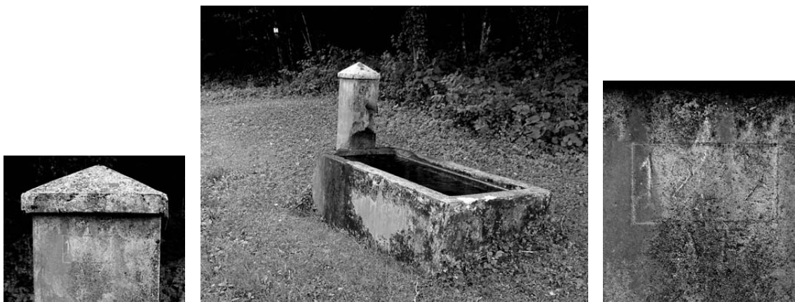
Ph. 25 Bac de Pré-Grevet (et détails de date sur le pilier, 1932 !)
