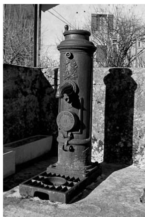
Ph. 43. Économique, l'eau coule seulement quand on tourne la manivelle !
